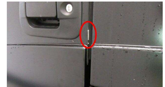
Éclat sur tranche de portes
