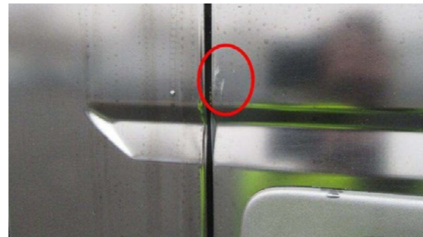
Éclat sur tranche de portes
