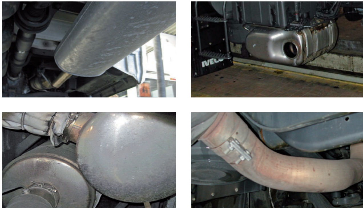
État conforme au contrôle technique
