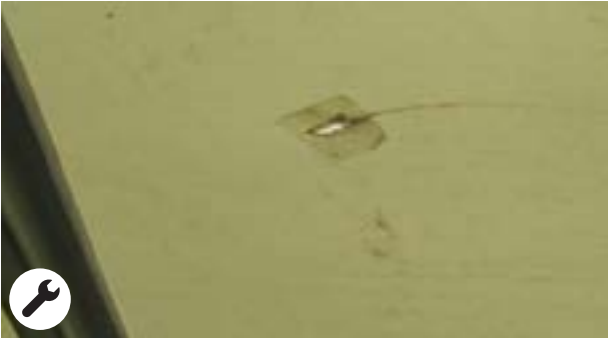
Dakruimte: Economisch verantwoord te repareren perforaties of scheuren
